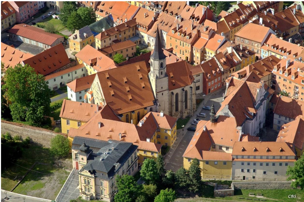
Areál františkánského kláštera a kláštera klarisek; střešní krajina Chebu
