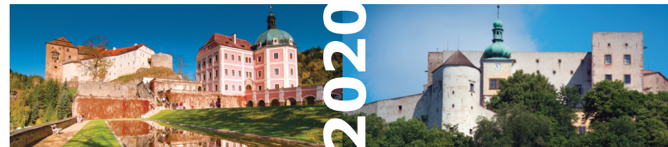
Bečov nad Teplou
